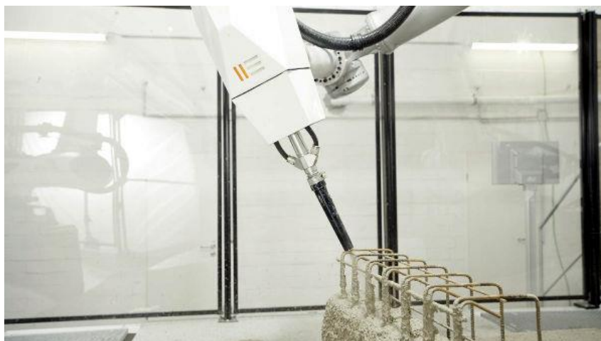
Рис. 3 – Строительная 3D-печать методом напыление бетона
