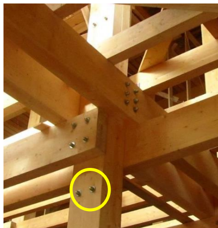
Рисунок 3 – Когтевая шайба типа «Булдого» и нагельное соединение элементов каркаса с ее применением
