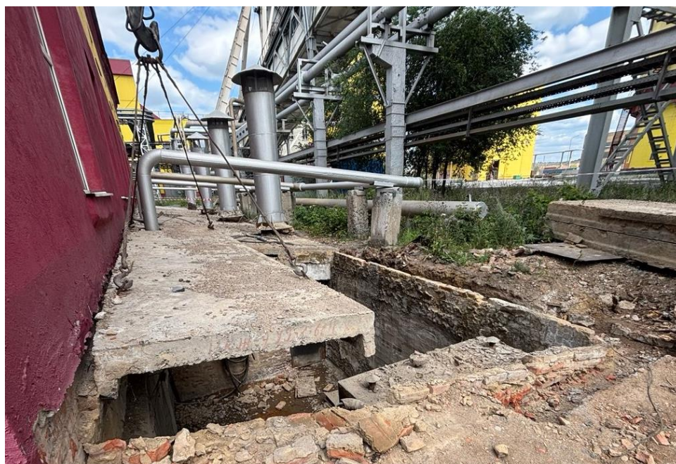
Рисунок 3- Фотофиксация демонтажа неработоспособного покрытия
