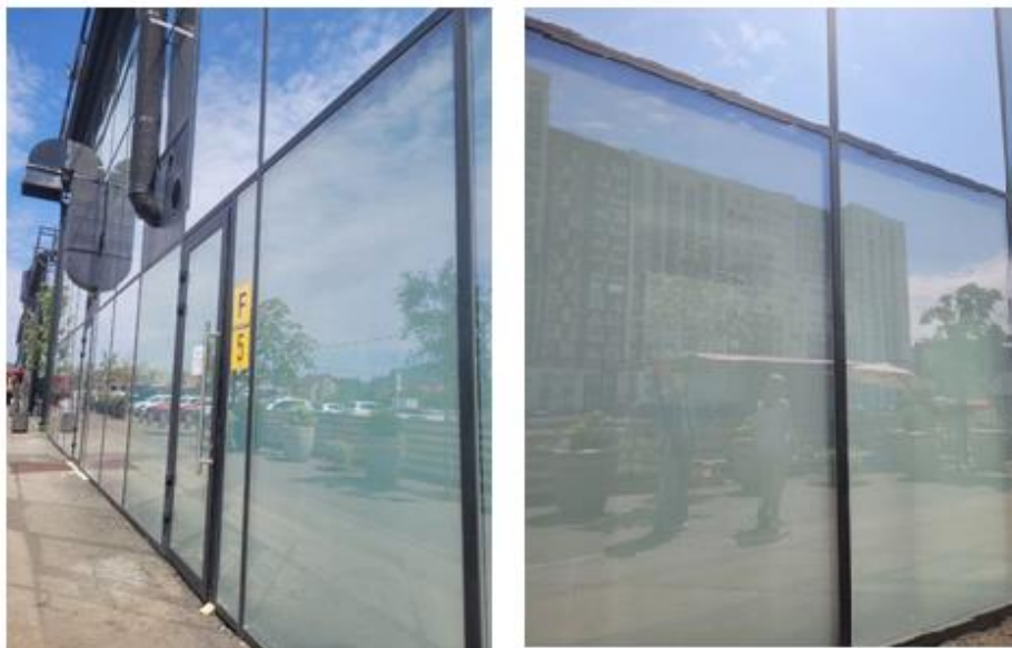
Рисунок 1 – Фасадное остекление здания «город Еды»
