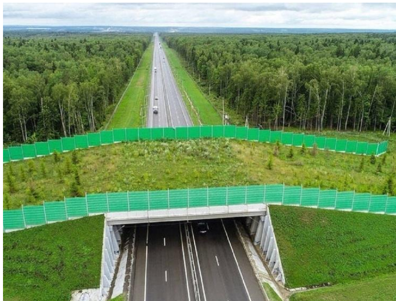
Рисунок 2 – Экодук на скоростной автомобильной дороге М-12 «Восток»
