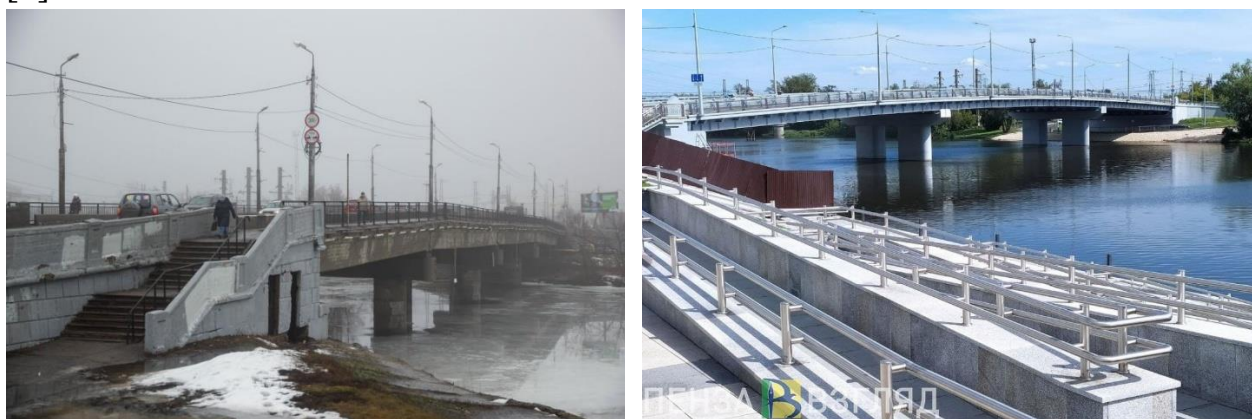
Рисунок 3 – Бакунинский мост (г. Пенза) до и после ревитализации
