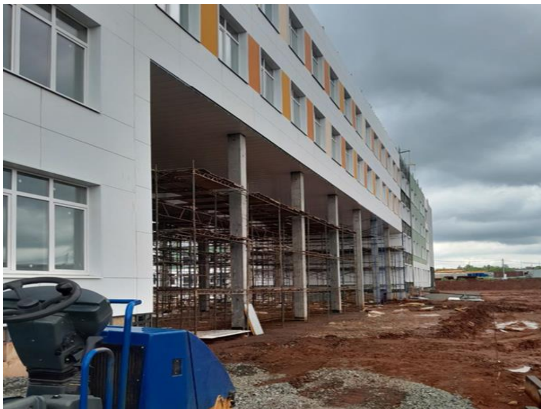
Рисунок 3 – Облицовка стен навесным фасадом из композитных панелей (каркасное здание школы на 1755 чел. По ул. Гаранькина г. Оренбург)
