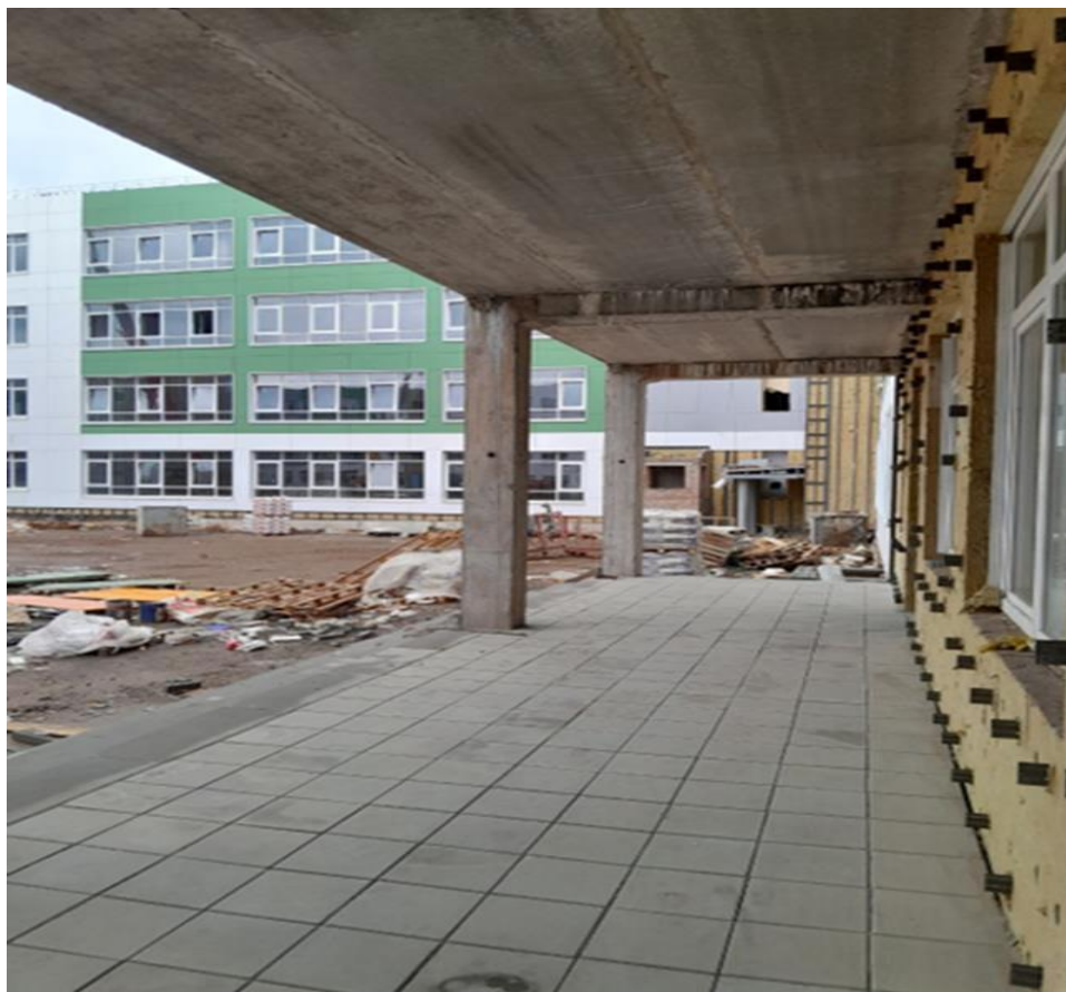
Рисунок 2 – Наиболее эффективный способ утепления наружных стен (каркасное здание школы на 1755 чел. По ул. Гаранькина г. Оренбург)
