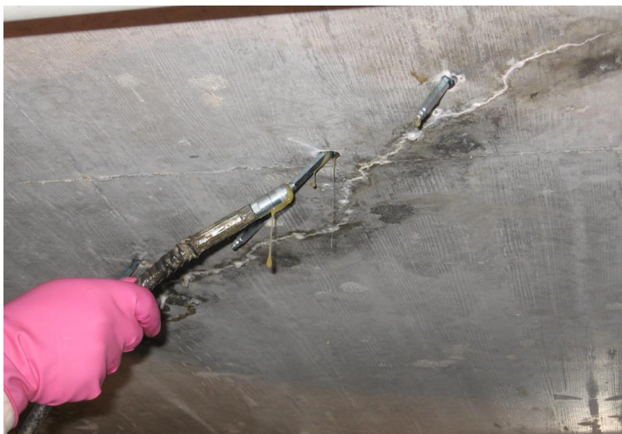
Рисунок 2 – Заполнение трещин или пустот в бетоне эпоксидными смолами, усиленными микроволокнами [5]
