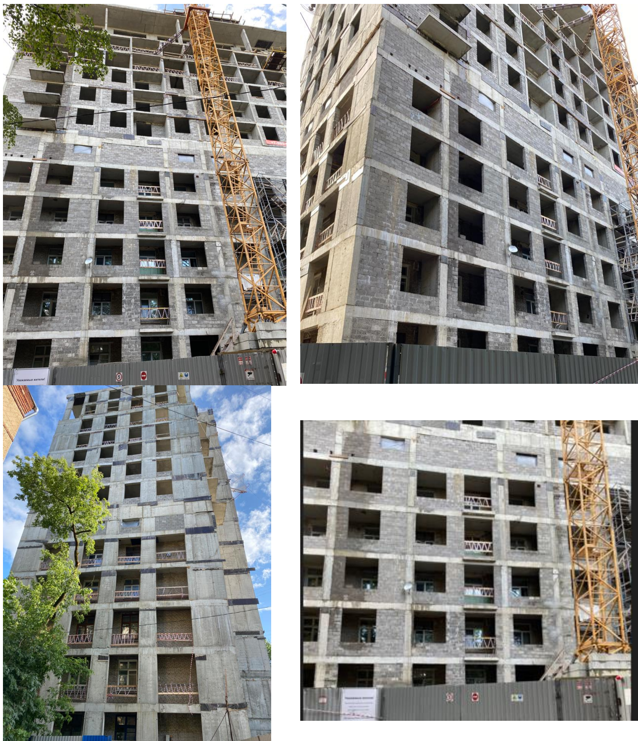
Рисунок 2 – Дом по адресу: бульвар Матроса Железняка, д. 11 в процессе реконструкции [4]
