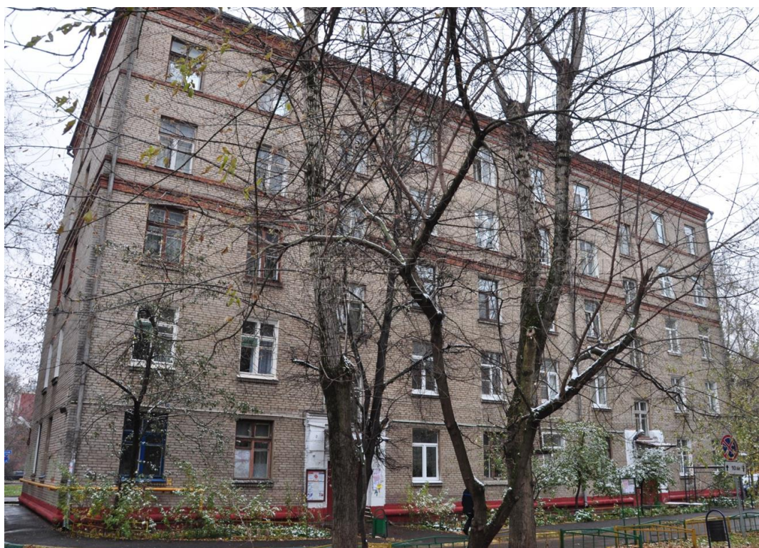
Рисунок 1 – Дом по адресу: г. Москва, бульвар Матроса Железняка, д. 11 [1]
